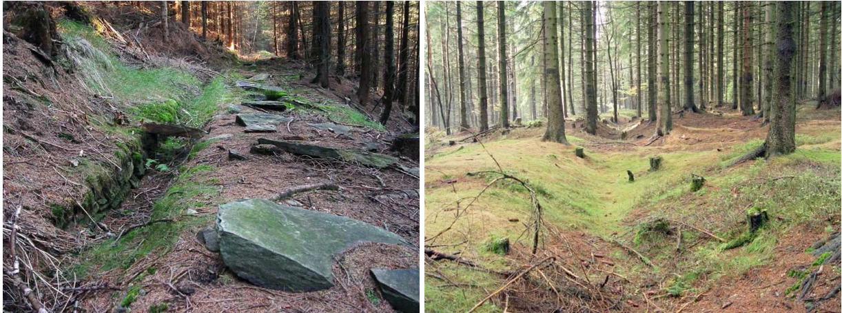
vodní struhy v jáchymovském okolí dodávaly energii k pohonu těžních strojů i zařízení úpraven
