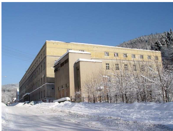
bývalá tabáková továrna (svého času druhá v Čechách) (původní byla o patro nižší)
