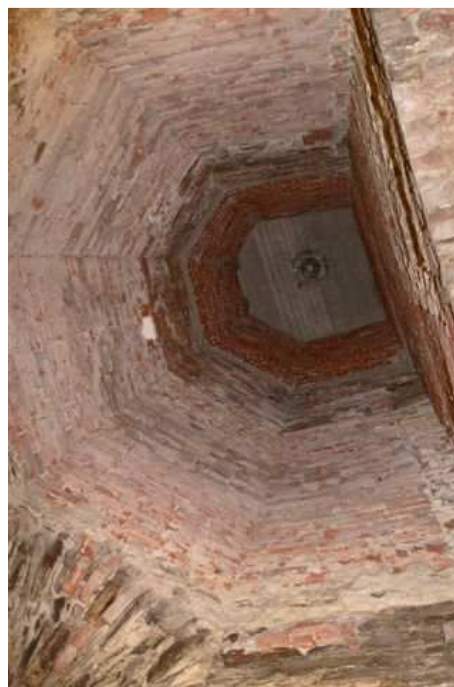
tzv. dymník odsával nežádoucí zplodiny z technologických provozů.
