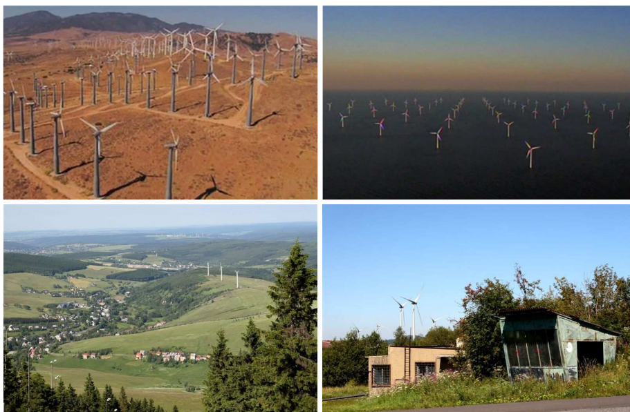
větrníky nepřekáží pouze v neobyvatelné krajině (nahore), v naší, hustě obydlené, jsou značně rušivým elementem (vlevo pohled z Klínovce, vpravo železniční zastávka Měděnec, 2008)
