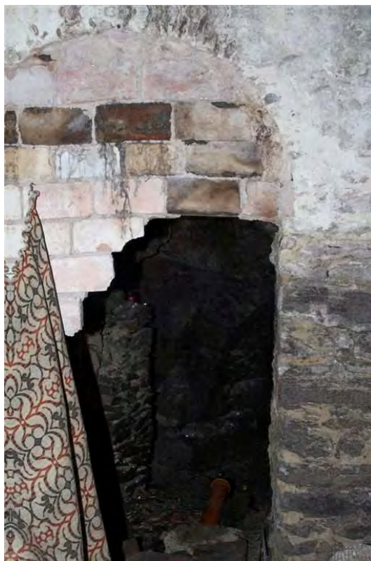
ukázka protiradonového „ozdravného“ opatření z počátku devadesátých let 20. století v Jáchymově; za to co vidíte, za zazdění štoly, stát zaplatil 250 000 Kč (stačila rána kladivem a byli jste za zdi) (2010)
