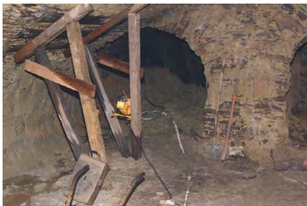
ukázka tzv. zabezpečení „nebezpečného důlního díla“ v kombinaci s protiradonovým opatřením (plechová ventilace)
