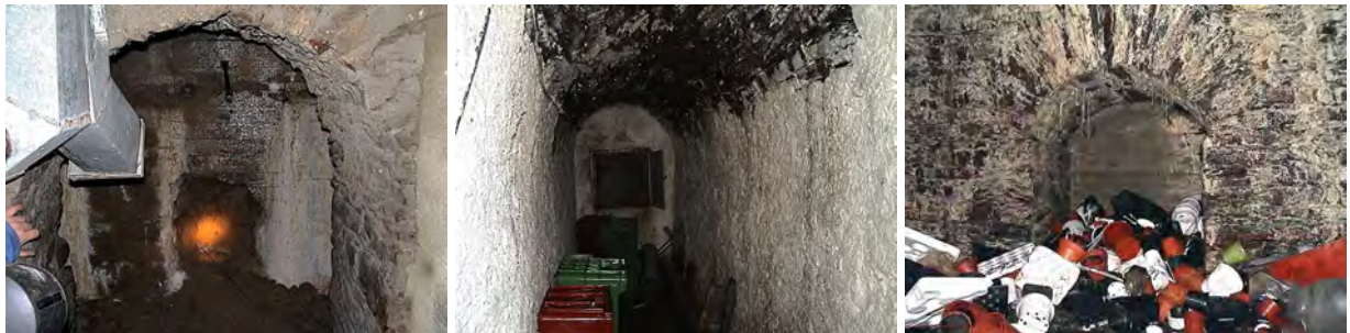
voda tekoucí po uzavěře, plíseň na stropě a překotně rostoucí brčka krápníků dokazují, že pouze cokoli zadržít jsou špatná řešení (2001)
